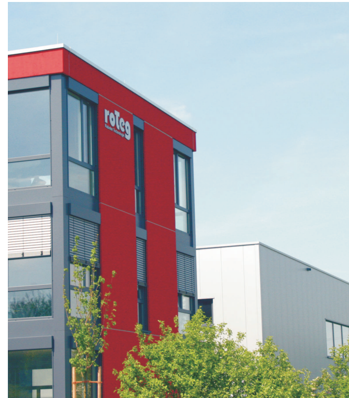
Verwaltung und Fertigungshalle
